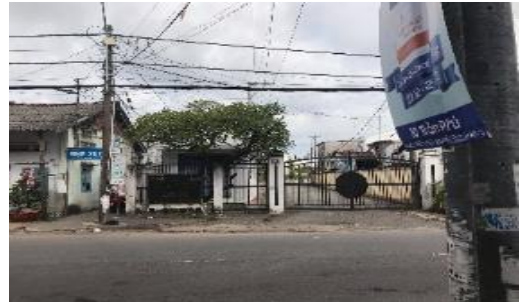
Nhà máy nước Rạch Giá Công suất 50.000m^3/ngđ
