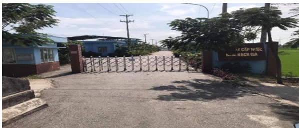
Nhà máy nước Nam Rạch Giá Công suất 20.000m^3/ngđ
